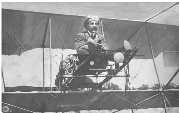
Ο Καμπέρος με το διπλάνο του κατά την απογείωση στο Φάληρο.
